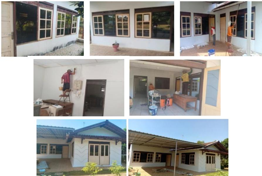
Gambar 83. Pengecatan Ulang Bangunan Dinding Tembok Pagar Kantor Bagian Luar dan Bagian Dalam
