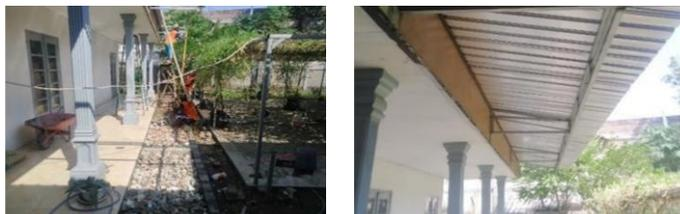
Gambar 78. Pemasangan Rangka Kanopi, Atap Spandex pada Teras di Depan Kantor IP2SIP Sumberrejo
