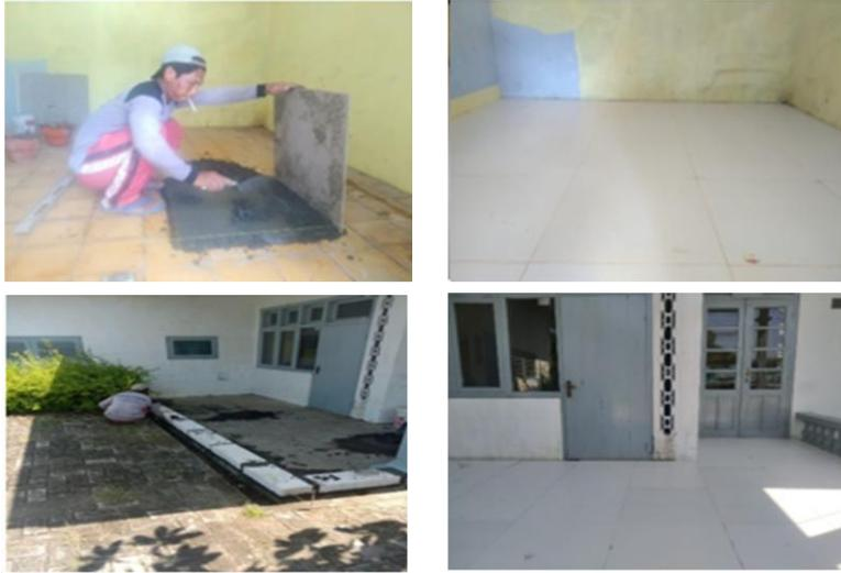
Gambar 74. Penggantian Lantai Tegel dengan Lantai Granit
