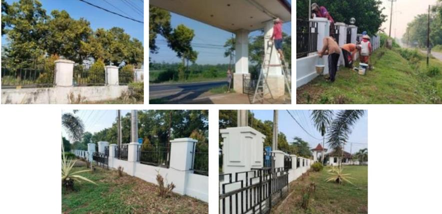
Gambar 82. Pengecatan Ulang Bangunan Dinding Tembok Pagar Kantor Bagian Luar dan Bagian Dalam di IP2SIP Muktiharjo
