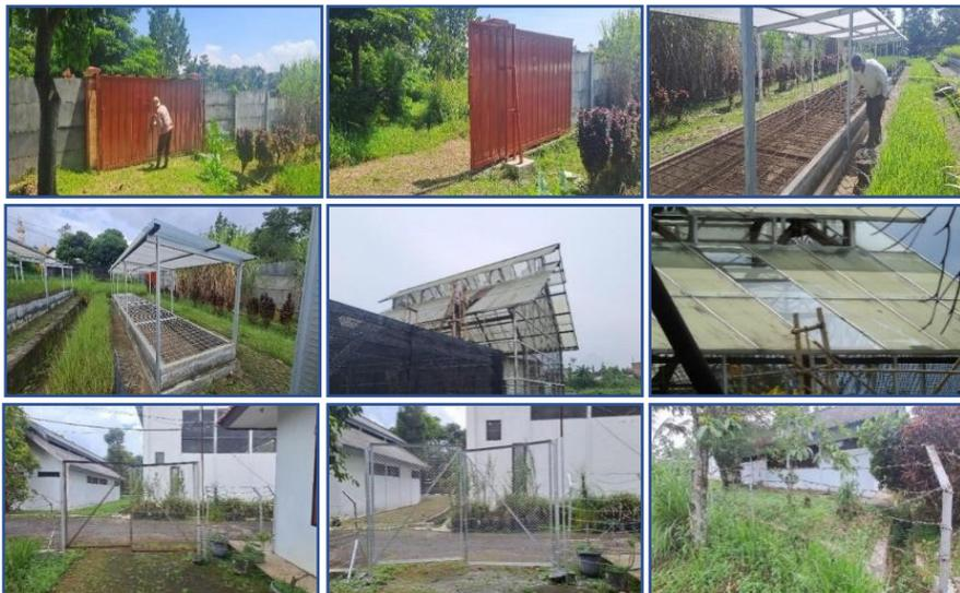
Gambar 64. Pengecatan Pintu Gerbang Sliding, Pengecatan Besi Teralis Nursery, Penggantian dan Pemasangan Atap Rumah Kaca dan Pengecatan Pintu Pagar dan Pagar Kawat Duri Sekeliling Kantor Kebun
