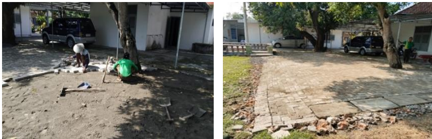
Gambar 57. Pengerasan Emplasemen dengan Pemasangan Batu Paving
