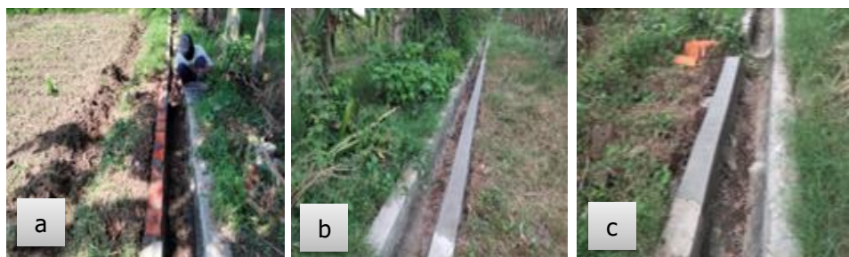
Gambar 64. Perbaikan Saluran Air
