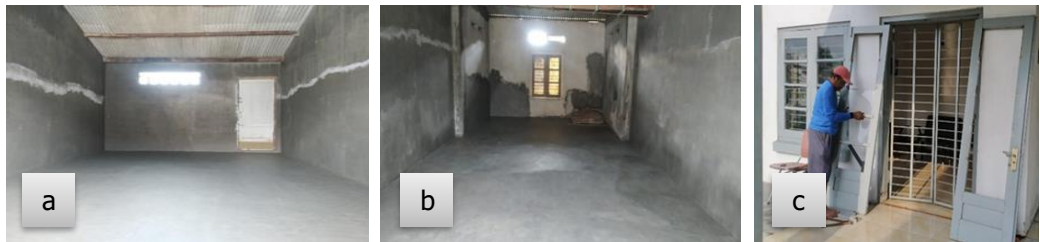
Gambar 53. Hasil Pemeliharaan Rumah Diesel (a); Rumah Handtractor (b) dan Penggantian Kaca (c)
