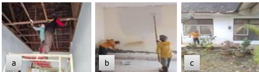
Gambar 60. Pemeliharaan Gedung di IP2MP Muktiharjo (a, b dan c)
