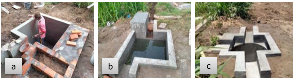
Gambar 66. Renovasi Bak Penampung Air Penyemprotan (a, b dan c)
