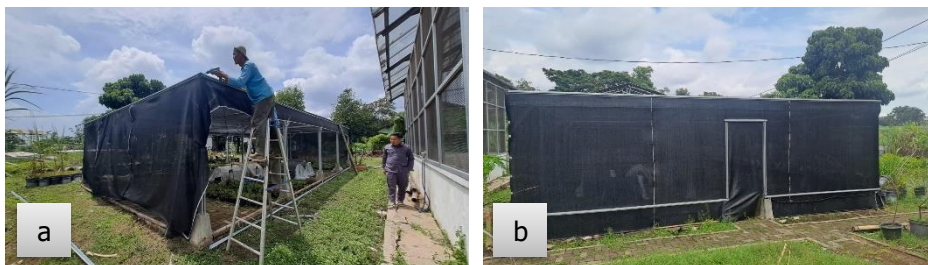
Gambar 47. Penjahitan & Pemasangan Paranet yang Baru dan Pemasangan Reng Galvalum
