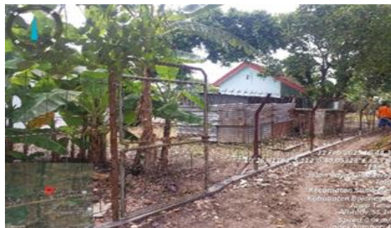
Gambar 52. Pagar Pembatas yang Telah Selesai Diperbaiki
