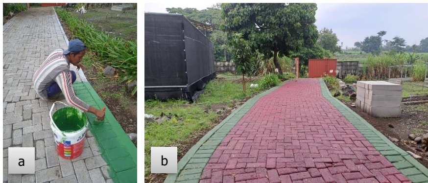
Gambar 51. Pembersihan dan pengecatan paving di IP2MP Karangploso
