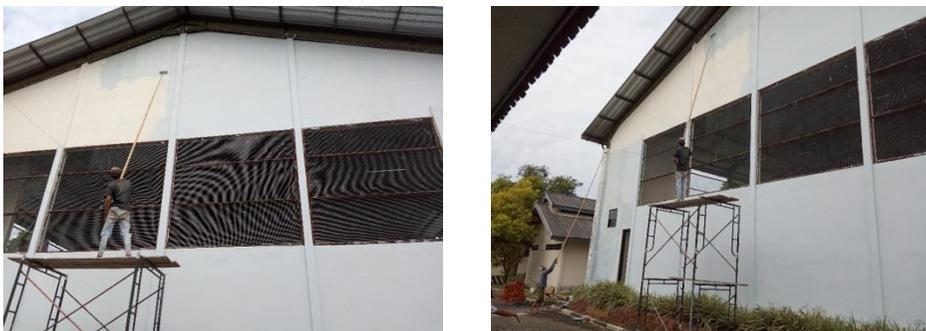
Gambar 4.5. Pengecatan dinding bagian luar dan pembersihan kawat harmonika pada gedung produksi di IP2TP Karangploso
