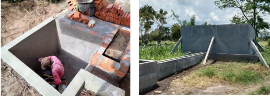
Gambar 4.7. Pembuatan tandon air dan saluran air
