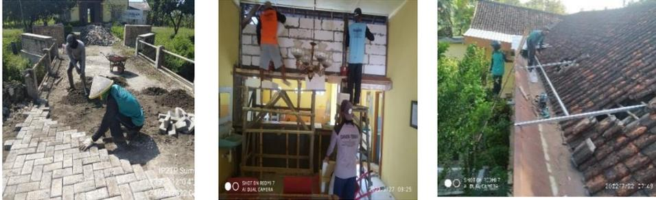
Gambar 4.13. Pemeliharaan sarana penunjang di IP2TP Sumberejo berupa pengerasan jalan, penggantian dinding mess, dan perbaikan talang bangunan kantor.
