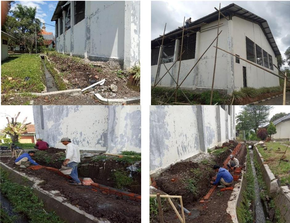
Gambar 4.4. Pemasangan talang dan talut pada gedung produksi
